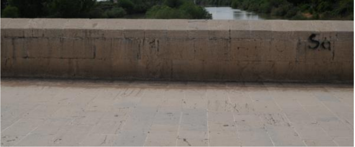
Görsel 18. Misis Köprüsü Açılan Korkuluk ve Tempan (kılıf duvarı) Taşları
