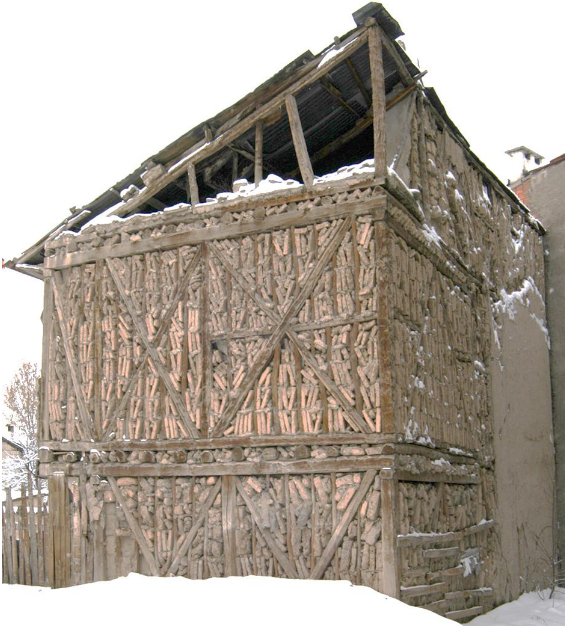
Görsel 15. Ahşap İskelet Arası Kerpiç Dolgulu Sistem, Sivas 2020 (Hımış Tekniği)
