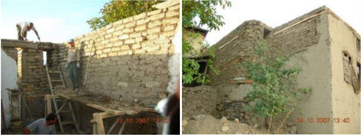
Görsel 12 - 13. Yığma Sistem Kerpiç Divriği Evi (Ede Evi Restorasyonu)
