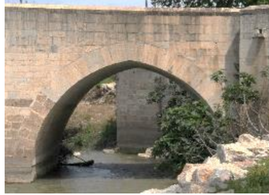
Görsel 2. Misis Köprüsünde Çift Merkezli Kemer Düzenlemesi
