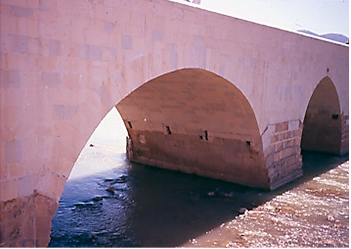
Görsel 8. Misis Köprüsü 2005 Mansap Köprü Ayağı Görünüş (yazar arşivi)
