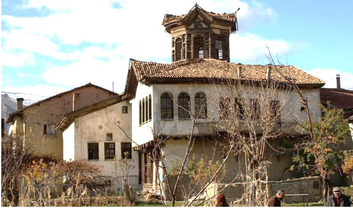
Görsel 7. Tevrüzlü Konağı Ayaz Cephesi
