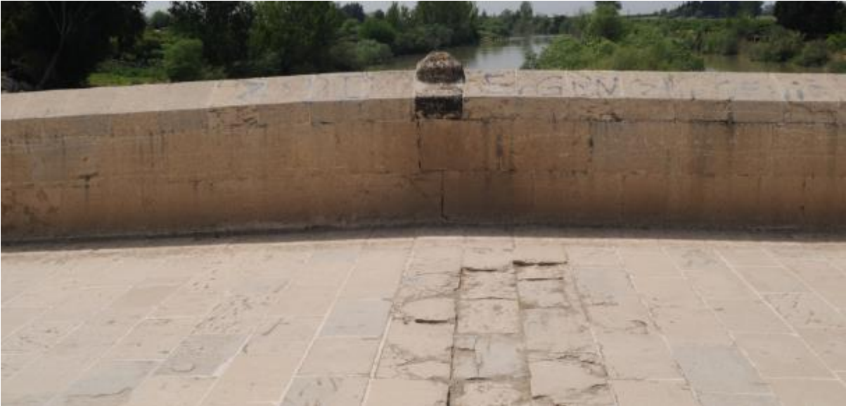
Görsel 19. Misis Köprüsü Açılan Korkuluk ve Tempan (kılıf duvarı 5. Göz) Taşları
